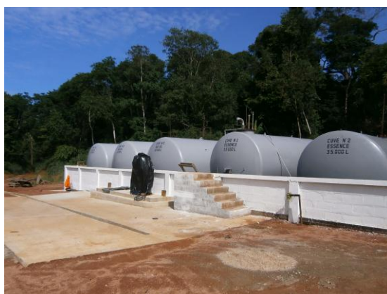
Photo 13 : Zone de stockage des carburants et station-service du garage de Lola (en cours de finition)
