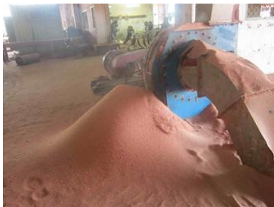
Photo 30: Défaillance du système d'aspiration
