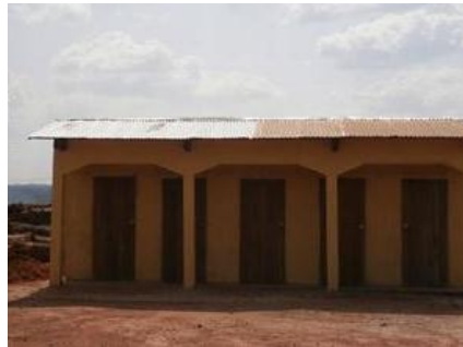
Photo 42 : WC pour le personnel des bureaux nouvellement construits sur le site de Moualé
