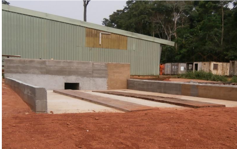
Photo 31 : Aire de lavage des engins et véhicules
