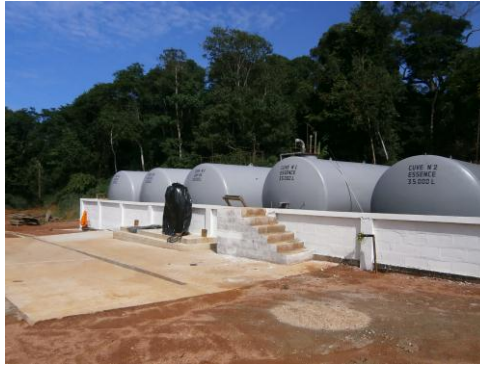
Photos 35 : Citerne avec bac de rétention et station-service avec une dalle bétonnée, en cours de construction par la société Mokabi
