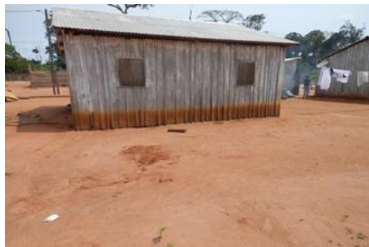
Photo 41 : Maison occupée par un travailleur au nouveau camp de Moualé sans arbre ni clôture
