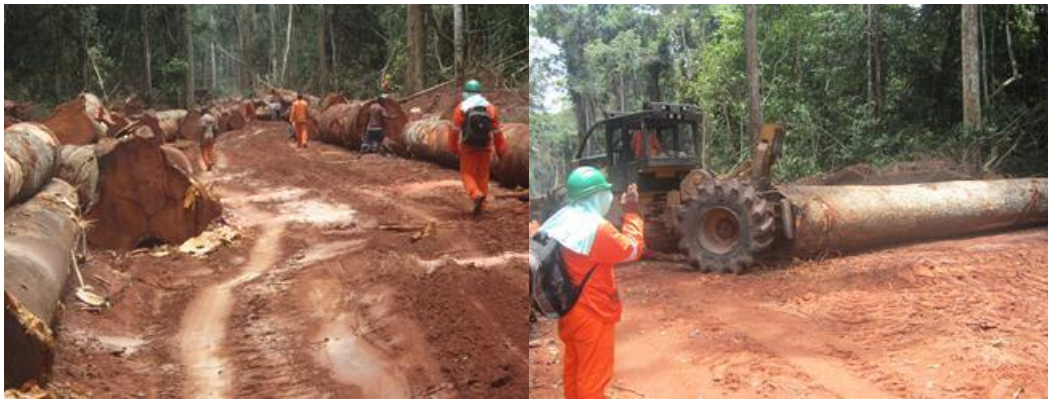
Photos 7: Stockage des grumes débardées le long de piste et opération de débardage au 528 à droite
