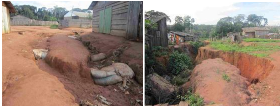
Photos 36 : Situation d'érosion et début de ravinement observé dans et autour des sites (Lola à gauche et Moulé à droite)
